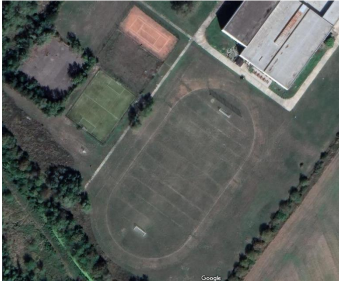
Stav športového areálu z Google maps (2022) - viditeľné čiary po odvodnení plochy pod ihriskom
